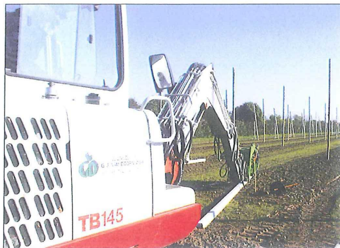
Het indraaien van de ankers en het plaatsen van de betonpalen wordt vaak in loonwerk gedaan.
